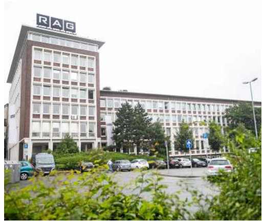
Das ehemalige RAG-Gebäude – hier eine Aufnahme von 2018 – hat eine neue Besitzerin und nennt sich jetzt „Bauknecht Quartier“. Es wird zu einem Bürokomplex umgebaut.
